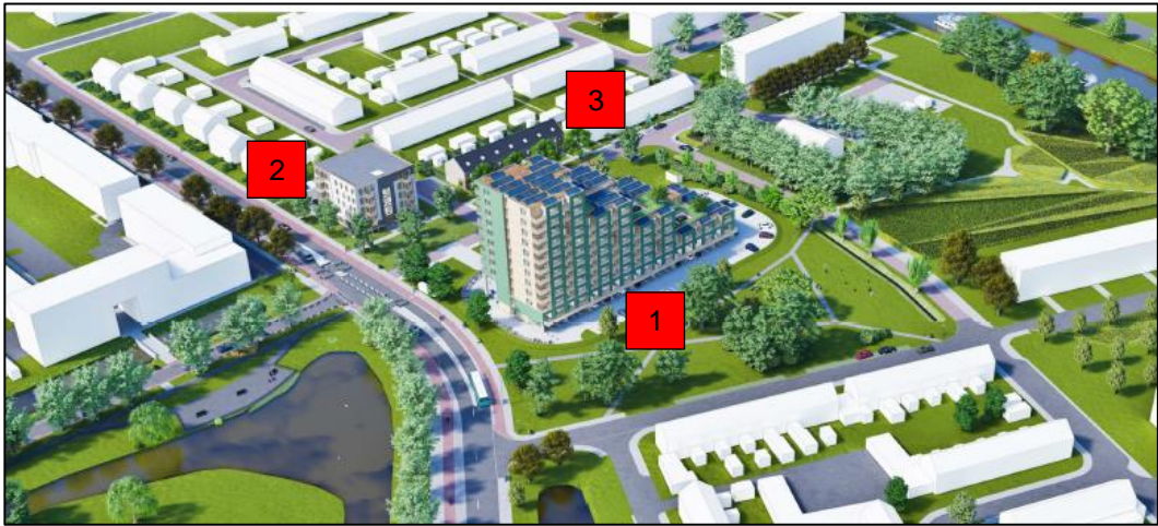
Figuur 2. Situatie met 'De Nieuwe Arend' (1), de 4 spanner (2) en de 7 rijwoningen (3) (bron: VMEZ Architecten).
