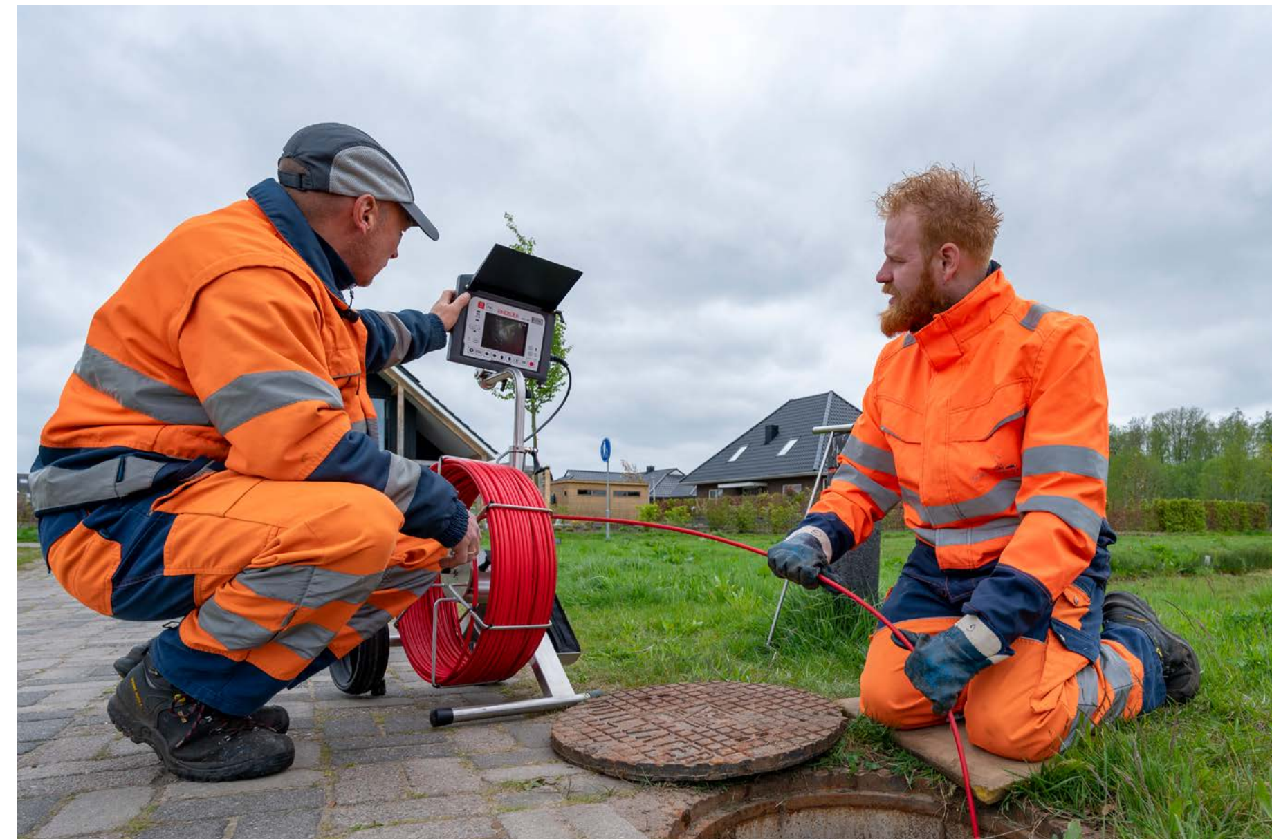
Rioolploeg en camera inspectie riolering
